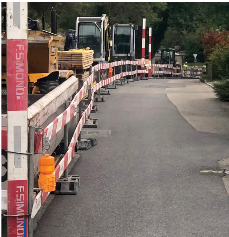
Le chantier du chemin de Treulaz.
