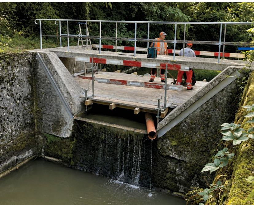
Passerelle du Moulin-de-la-Ratte
